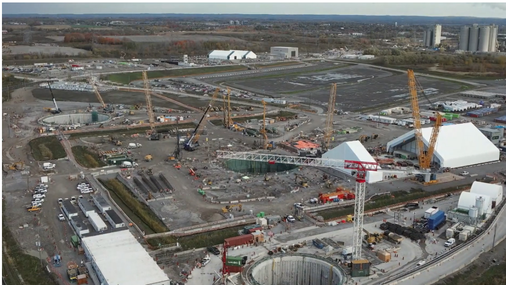
Figuur 6: Bouwplaats van BWRX-300, locatie Darlington in Ontario. Fotocredits GE Vernova
